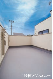
4号棟バルコニー
