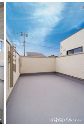
4号棟バルコニー
